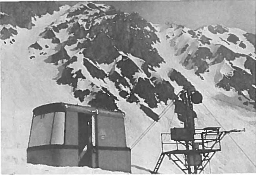
Abb. 5: Meßkabine. Rechts: Antriebsstation einer Lawinensprengseilbahn mit meteorologischen Instrumenten
